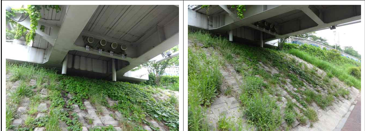
배수시설 A2 전경(양호)
