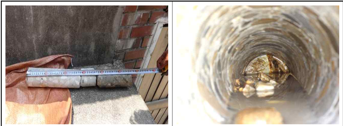
SPAN 9 TYPE3 코어 채취 및 제원 확인
