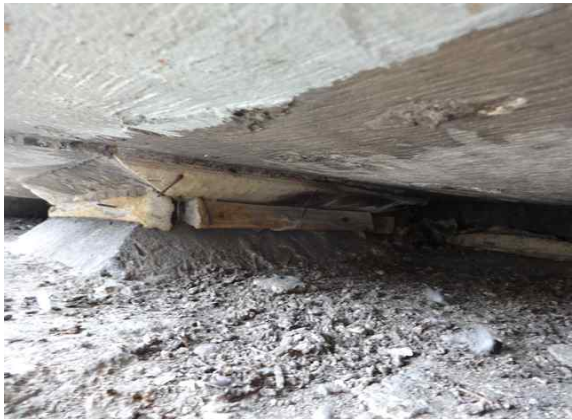
교량 받침 전경
