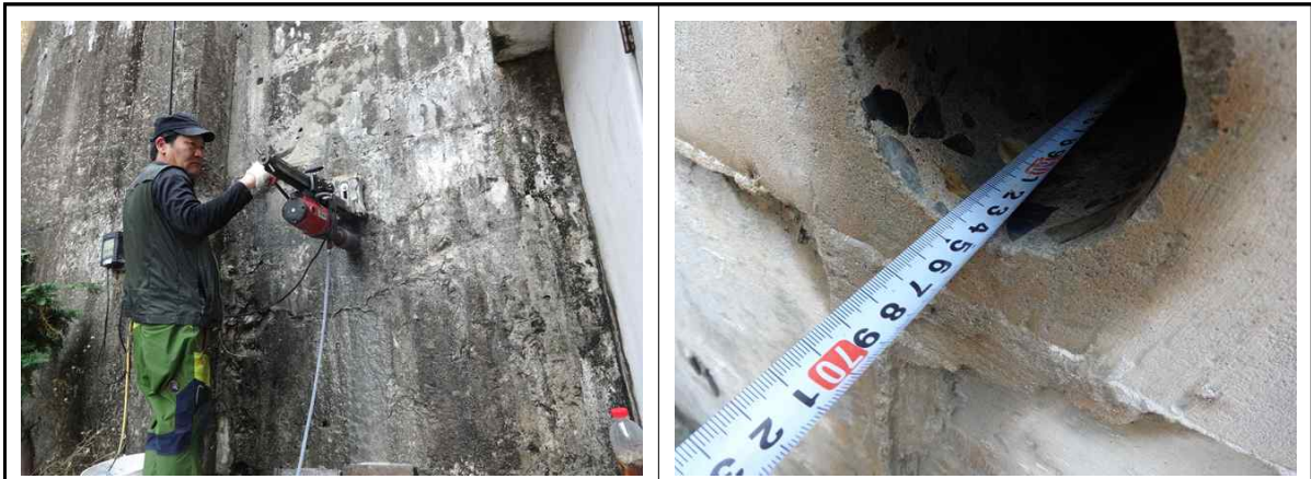
SPAN 6 TYPE2 코어 채취 및 제원 확인
