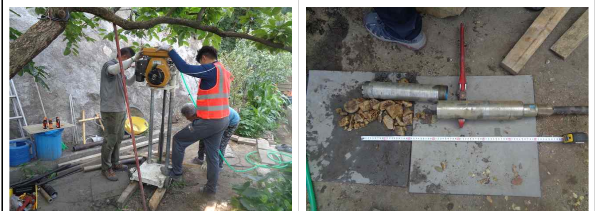
SPAN 4 TYPE2-1 노인복지센터 구간 지반 상태 확인
