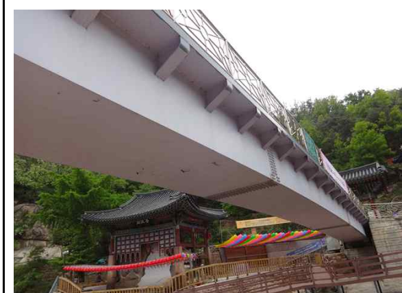
거더 외부 전경
