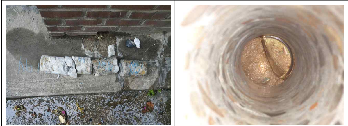
SPAN 6 TYPE2 코어 채취 및 제원 확인
