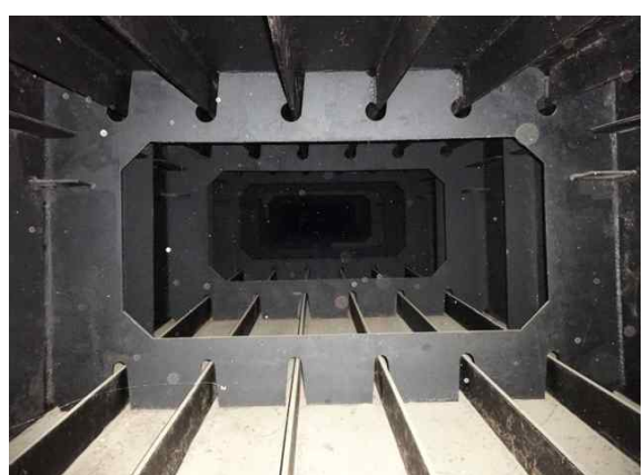
거더 내부 전경
